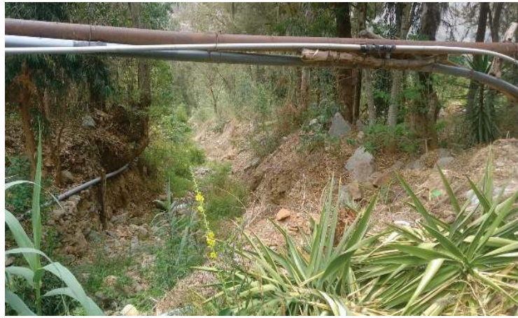
FIGURA N°02: TUBERIAS DE AGUA EXPUESTA A UNA POSIBLE INUNDACION DE LA QUEBRADA TOLLOCOTO , DISTRITO DE TOMAYKICHTWA, PROVINCIA DE AMBO , DEPARTAMENTO DE HUANUCO
